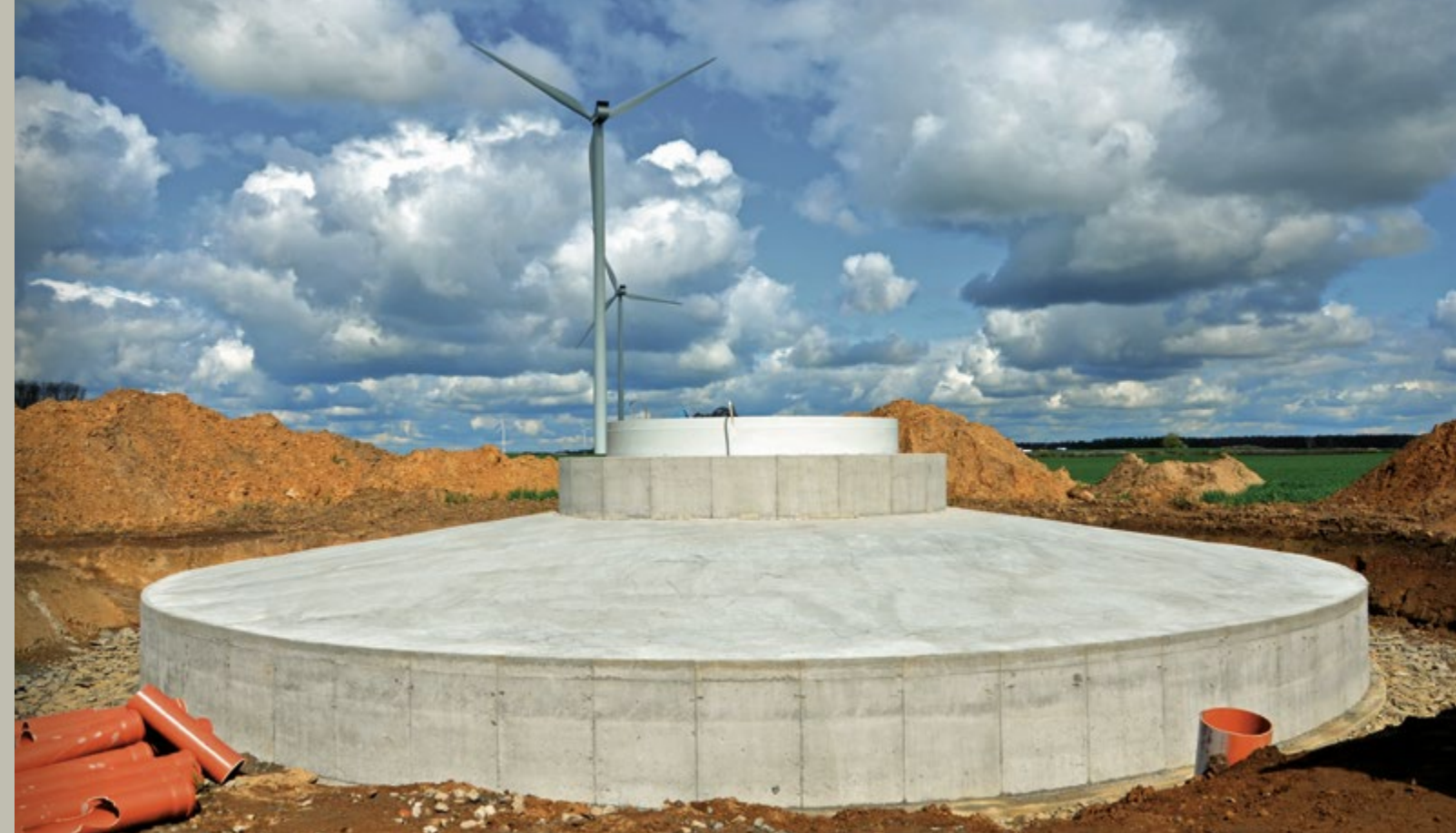
Heimische Rohstoffe für die Energiewende: Für das Fundament einer Windkraftanlage werden ca. 700 Kubikmeter Beton benötigt, bestehend aus rund 1.500 Tonnen Gesteinskörnung und Zement.
