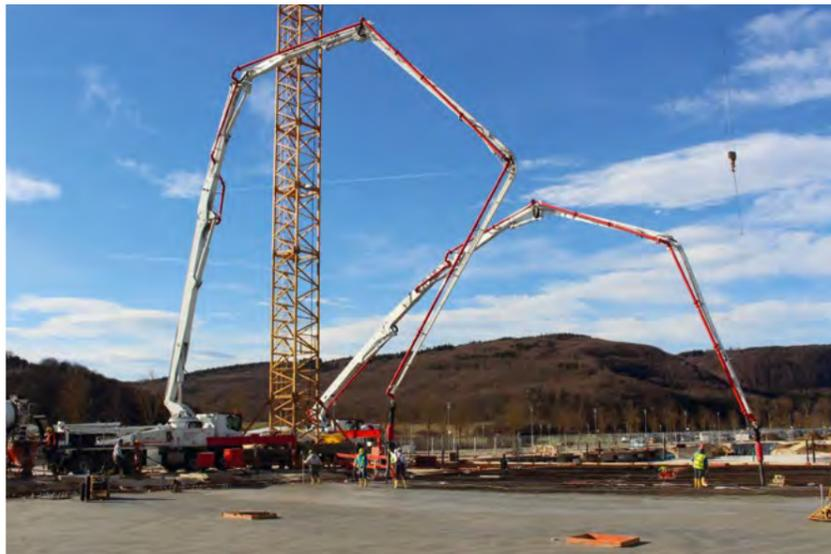
Große Bauvorhaben im Infrastruktur-, Wirtschafts- oder Wohnungsbau erfordern effiziente Transport- und Einbaulogistik: Betonpumpen fördern den Frischbeton direkt zum Einbauort mit beliebigen Förderstrecken oder Pumphöhen.
