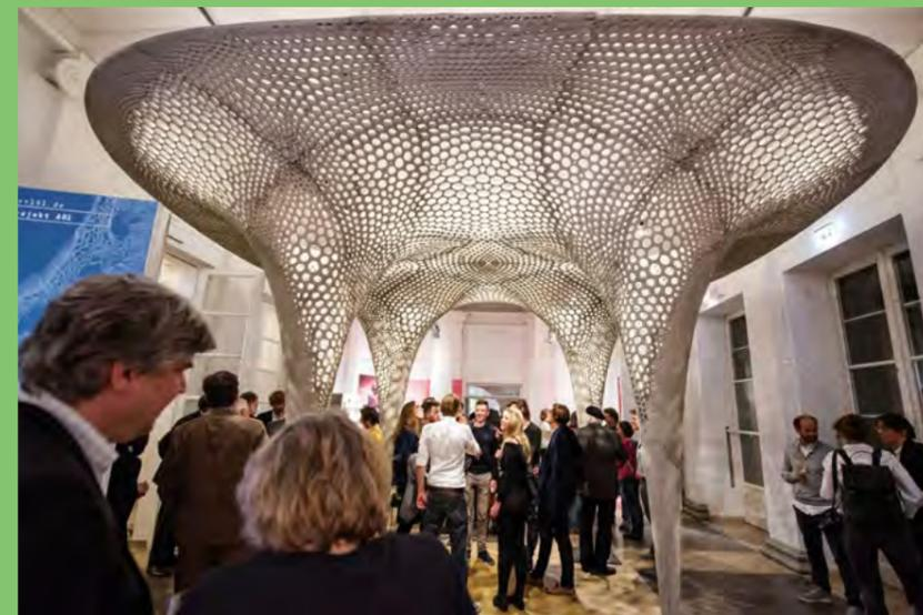
Die Anordnung der Poren des Anima-Pavillons basiert auf dem Spannungszustand innerhalb der Konstruktion. Die Porenstruktur erlaubt eine signifikante Reduktion des Eigengewichts des Pavillons unter Beibehaltung der Tragfähigkeit.
