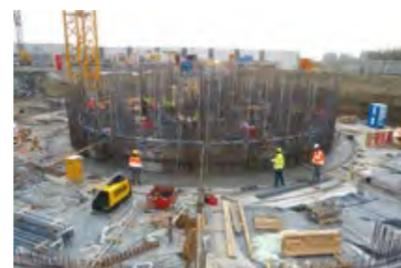
Ein Turm wächst in die Höhe: Beginn der Gleitschalung – ab jetzt wächst der Turm mit 15 cm /Stunde oder 3,60m/Tag.
