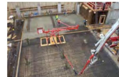
Der Rundverteiler auf Betonstahl erweitert und rationalisiert den Betonpumpeneinsatz.
