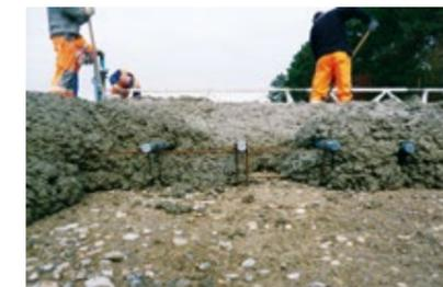
Betonierarbeiten direkt auf die modifizierte Kiestragschicht
