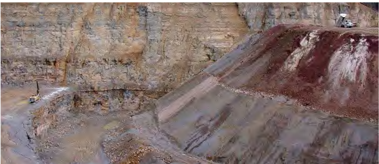
Abbildungen 7 und 8: Verfüllung von Steinbrüchen
