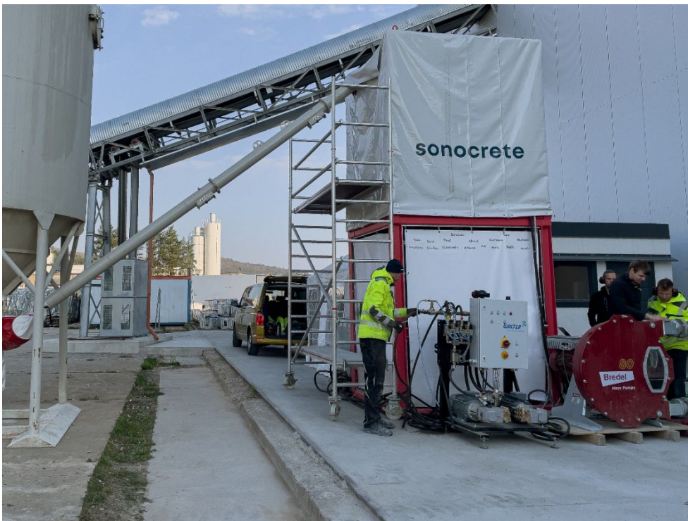
Der Sonocrete-Effekt: Mithilfe von Hochleistungsumschall wird eine bessere Früh- und Kompressionsfestigkeiten bei Fertigbetonen mit geringem Klinkeranteil erreicht. | Foto: Sonocrete
