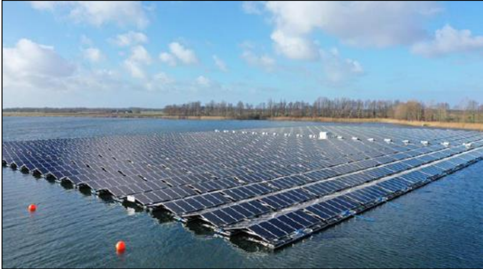
Abbildung 2: FPV-Anlage mit Ost-West-Aufständigung. Quelle: Zimmermann PV-Stahlbau, abgedruckt in: Baltins et al., „Floating PV: Ein Leitfaden für Deutschland“, Fraunhofer ISE, 2025, S. 19.
