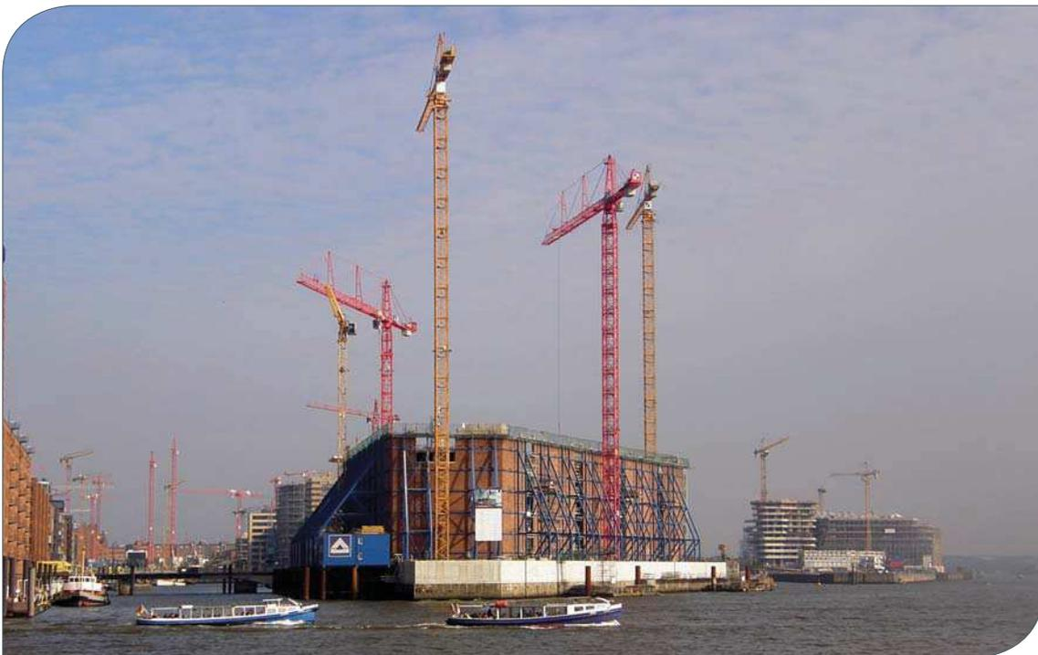
**Abb. 1:** Die Baustelle der Elbphilharmonie in Hamburg im Oktober 2008. Allein für die Herstellung des verbauten 63.000 m<sup>3</sup> Transportbetons (s. Text) wurden rund 41.000 t Bausand hoher Qualität benötigt, Foto: Emma7stern/Wikipedia .
